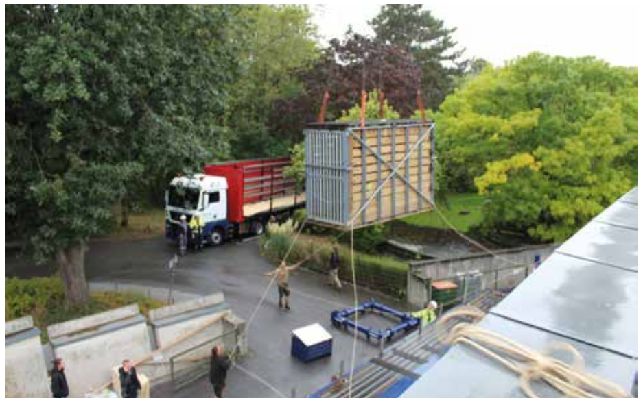
Abb. 21: Ein Schwerlastkran hebt eine der Transportkisten über das Dach des Elefantenhauses.
