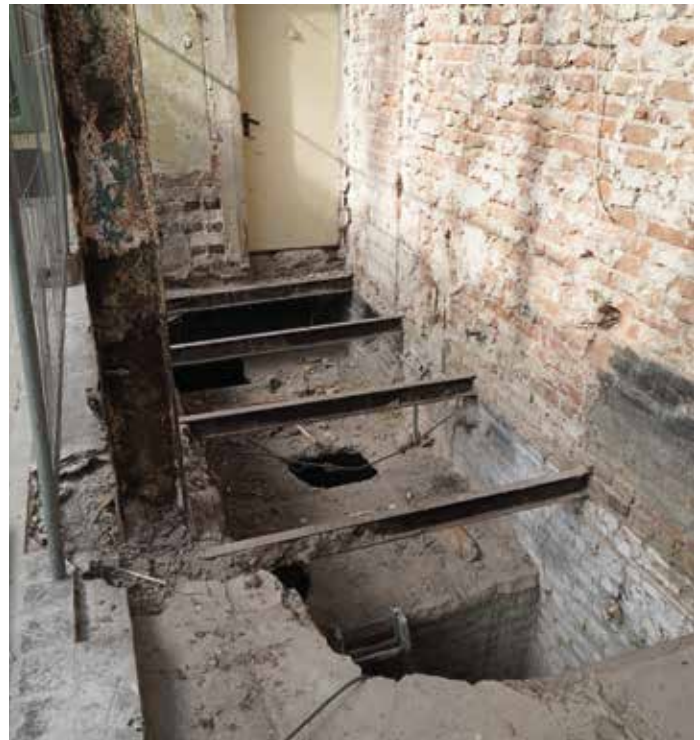
Abb. 87: Stahlträger im alten Südamerikahaus. Steel beams in the South America House.
